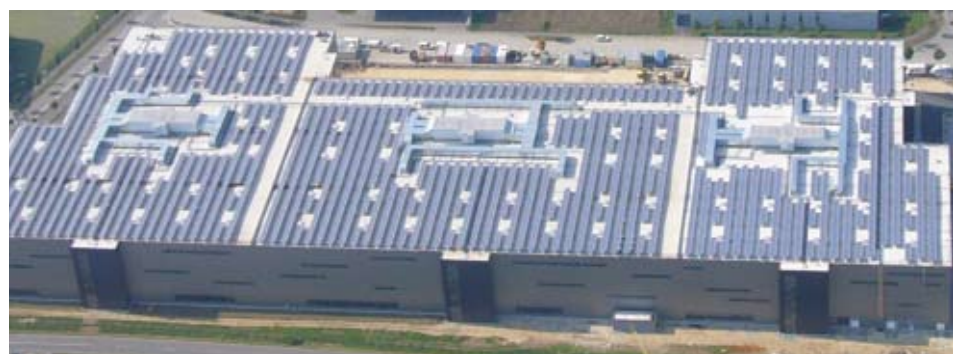
1MW-Anlage, Aufdachanlage, Holy-AG (Deutschland) 1MW Installation (Germany)
