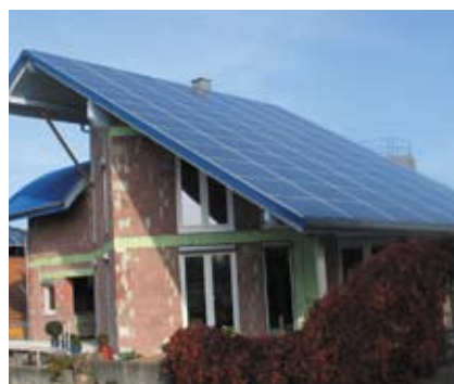
17kW-Anlage, Aufdachanlage (Deutschland) 17kW Installation (Germany)
